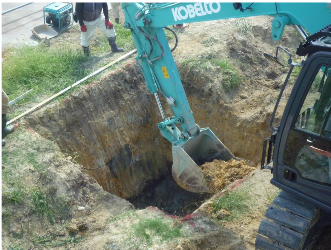
② 重機による掘削状況
