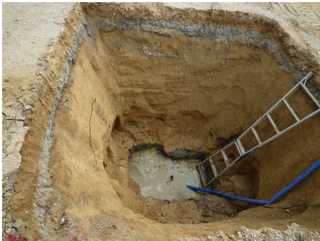
③ 調査杭内の湧水の状況
