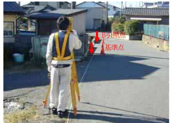
A引照点でのTSによる視準(A引照点～基準点～B引照点)
