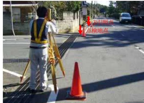
A引照点でのTSによる視準 (A引照点～点検地点～B引照点)
