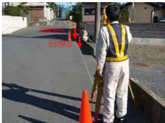
A引照点でのTSによる視準 (A引照点~B引照点~点検地点)
