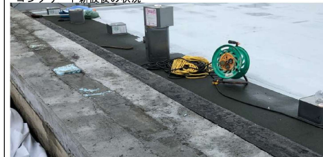
コンクリート新設後の状況
