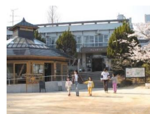
図 5-6 甲山自然環境センター
