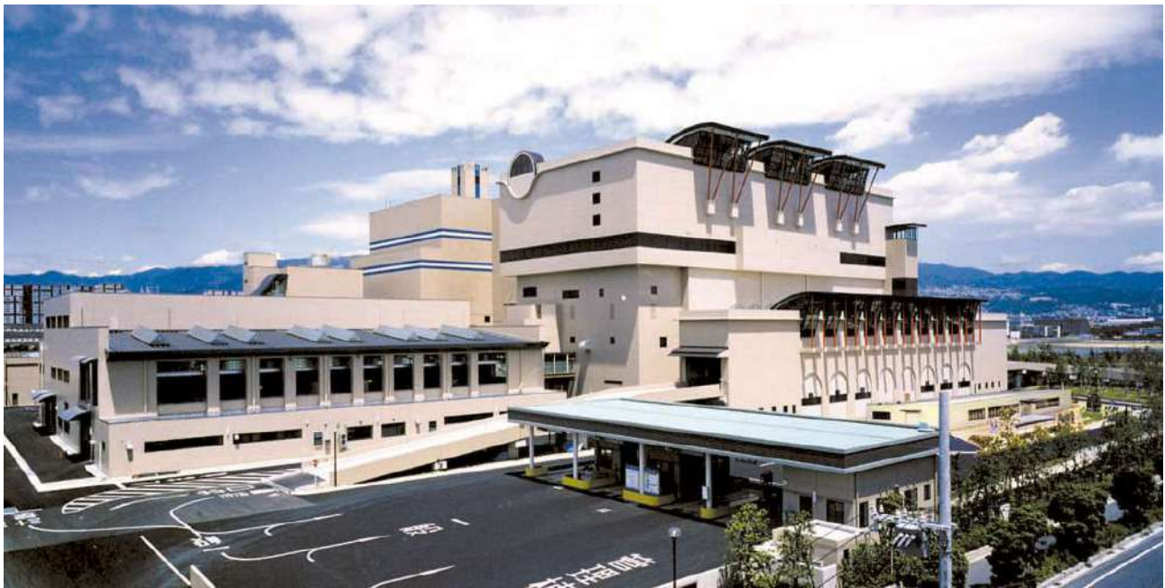
西部総合処理センター
