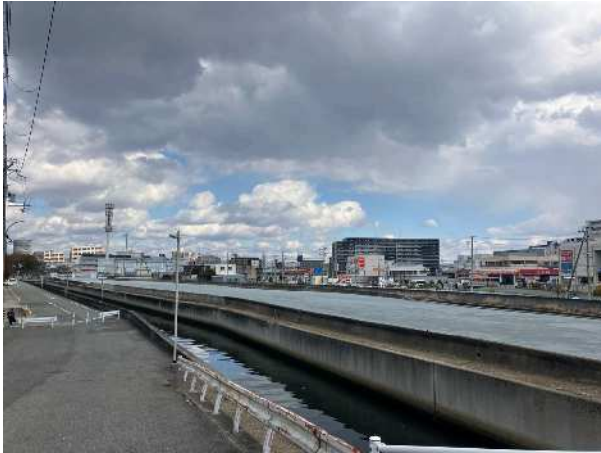
施工完了（南西）
