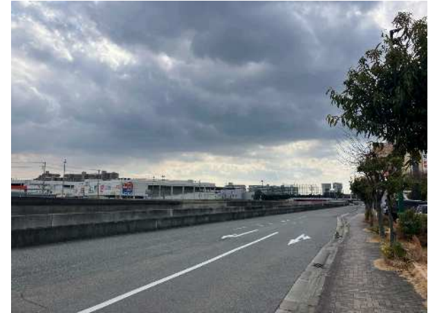
施工完了（北西）
