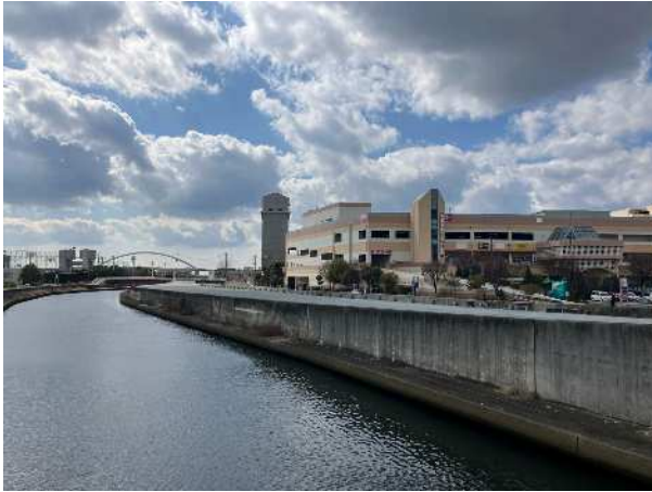
施工完了（北東）
