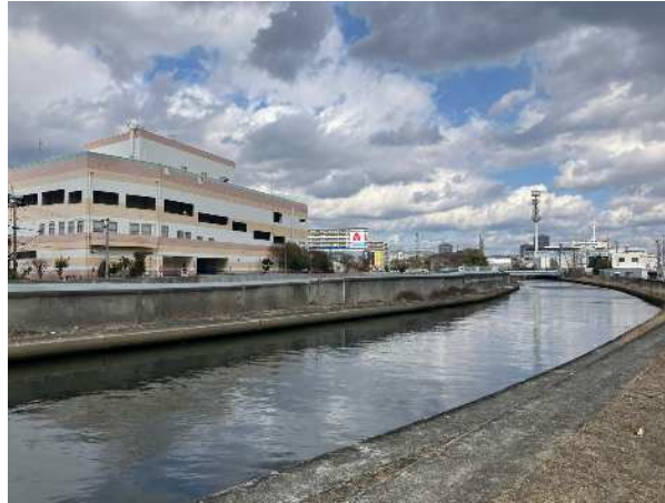
施工完了（南東）
