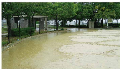
道路に水があふれ出ないように水を貯めています (あらきの森公園)
