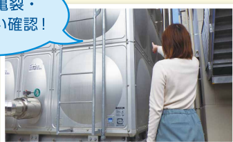
受水槽の目視確認
