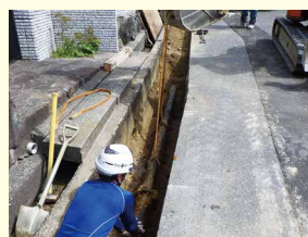
不要となった管の撤去作業
