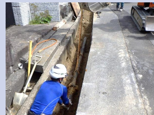
（水道管の布設工事の写真）
