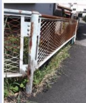
腐食した転落防止柵の更新
