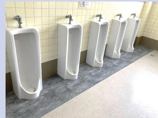
（改修後のトイレ）
