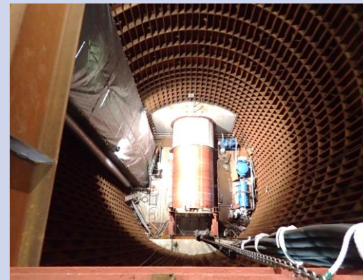
（合流貯留管の整備）
