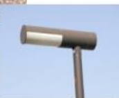
腐食した道路照明灯の更新・LED化
