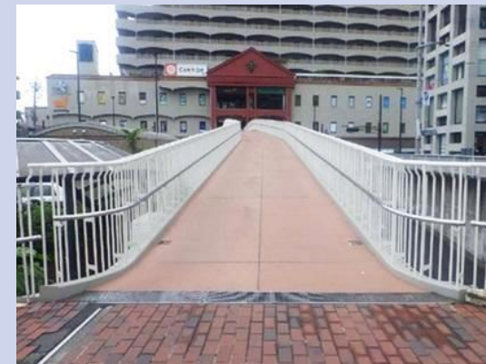
（羽衣町歩道橋）
