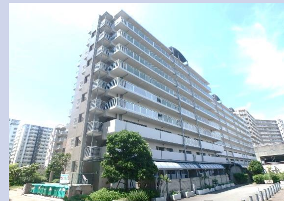
（外壁改修後の市営住宅）
